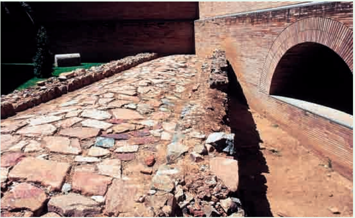
Calzada romana rehabilitada
